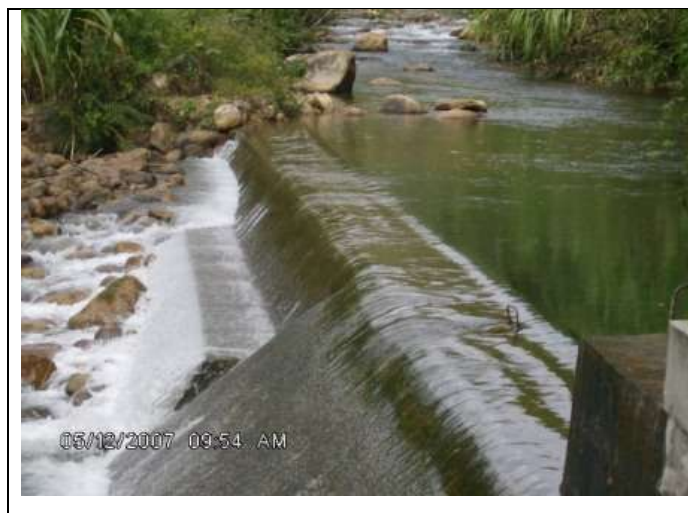
Fotografía 1 Vista del Río Tame aguas arriba de la captación
