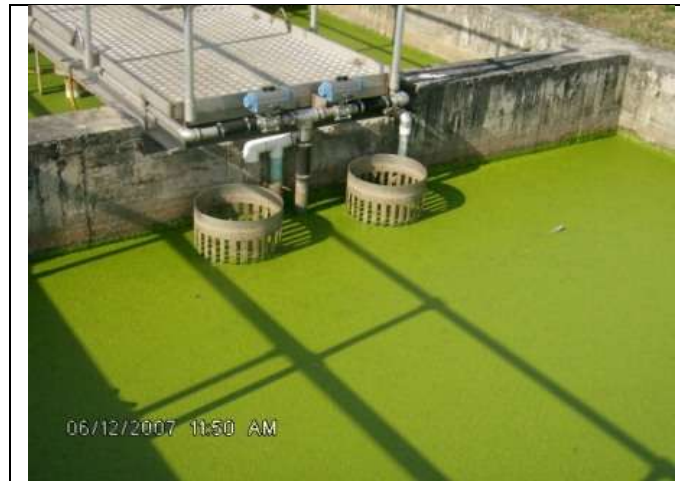
Fotografía 10 PTAR La Vicha.
